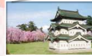
曳屋工事後の本丸(イメージ)
