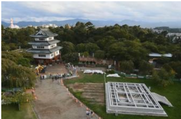
2015年曳屋工事の様子
