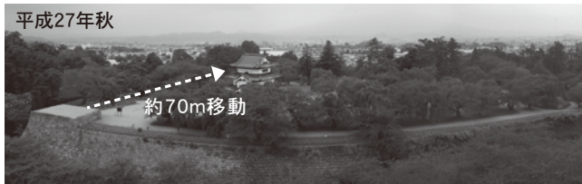
天守曳屋工事想定図／天守は本丸中央部へ約70m移動します。曳屋工事中も本丸へは入場できます。
